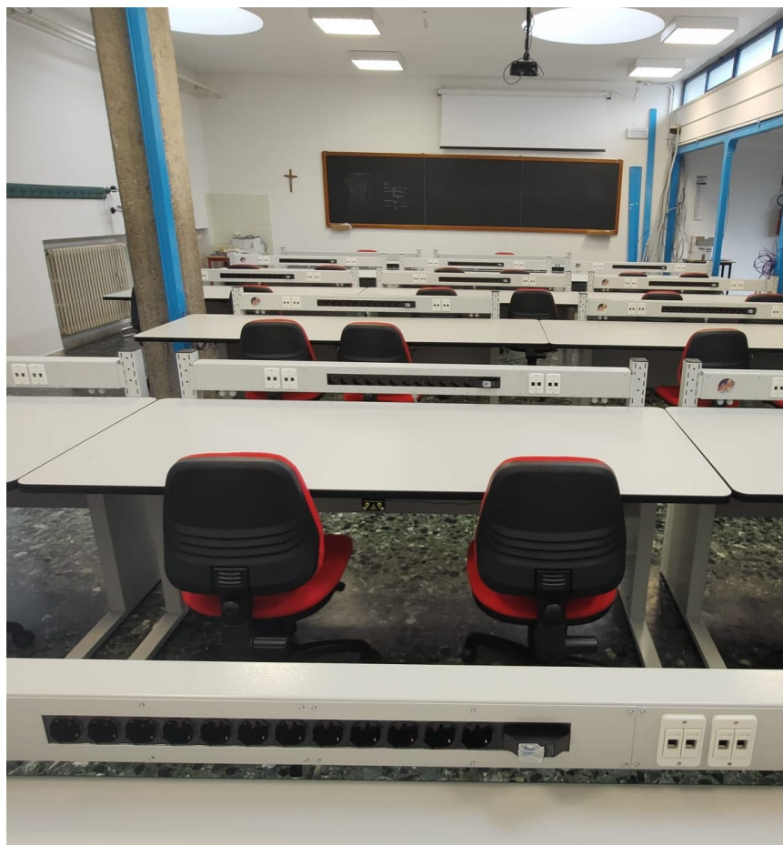
Martedì 13 luglio 2021, conclusione dei lavori con il completo rifacimento del Laboratorio LEN4 (con nuovi banconi e nuove sedie).
